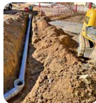
追加した排水設備工事
