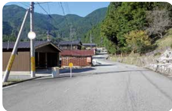
工事着手されない県道加美穴栗線（上小田地内）
