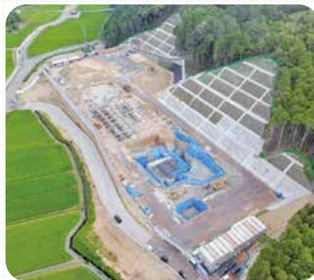
令和8年6月末時点の工事状況
