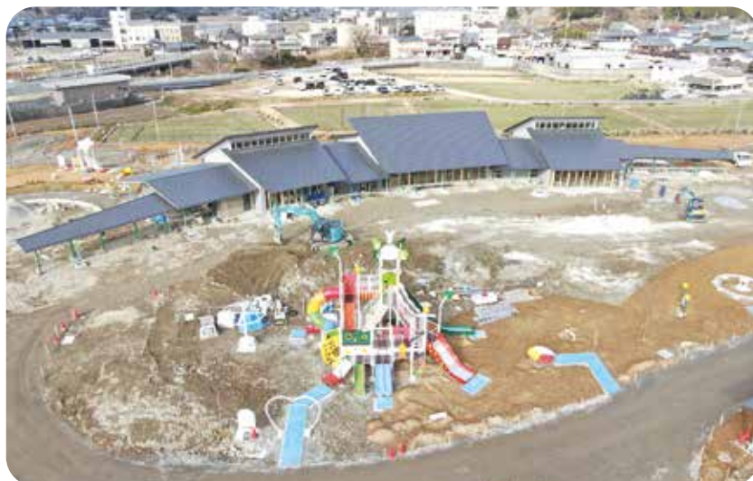
令和7年1月時点の工事状況
