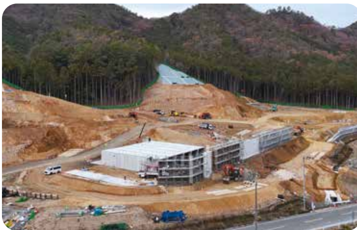
令和6年12月時点の新ごみ処理施設の建設状況 (市川町浅野地区)
