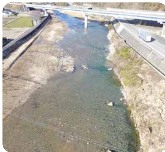
越知川の河床整正後（貝野区）
