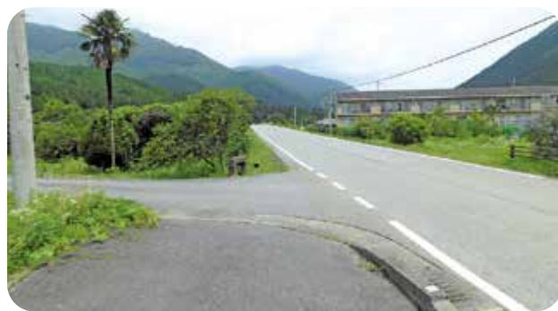
歩道がない国道312号線 (大黒茶屋北杉地内)
