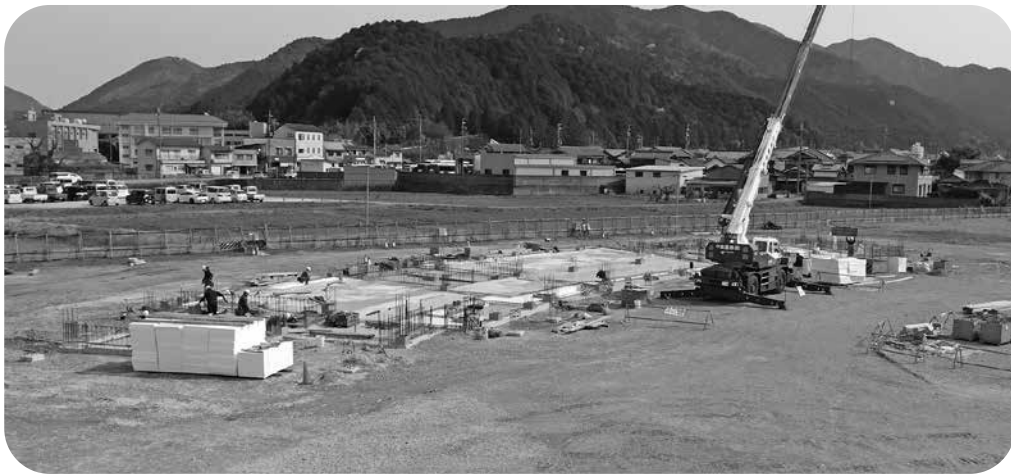
公園・図書コミュニティ施設の工事状況 (令和6年4月5日時点)
