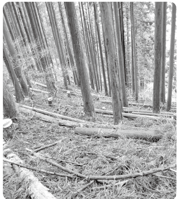
土砂崩れを防止するため、間伐材を土留めで設置しています
