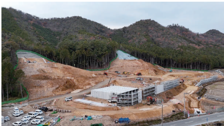
▲施設建設用地の造成工事の状況(令和6年12月20日撮影)
