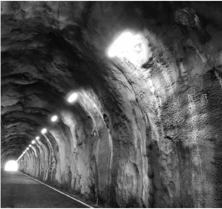
壁面工事後の水ノ谷トンネル（大川原区）
