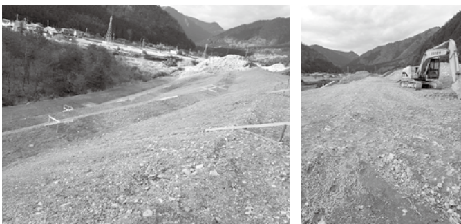
ニガ竹建設残土砂等処分地工事
