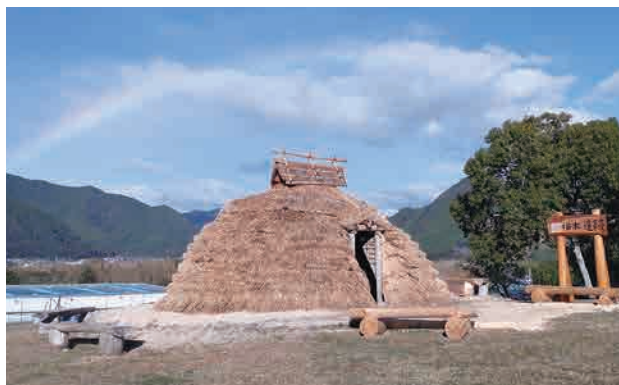
▲茅葺き屋根が新しくなった竪穴住居。お披露目の当日は虹がかかりました。
