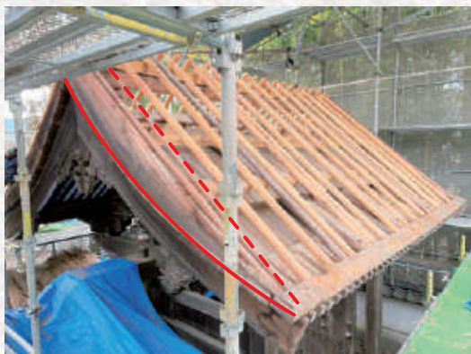
▲茅を取り外した状態 (実線:元々の屋根 点線:現在の屋根)
