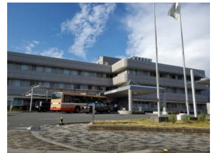
公立神崎総合病院（令和2年撮影）
