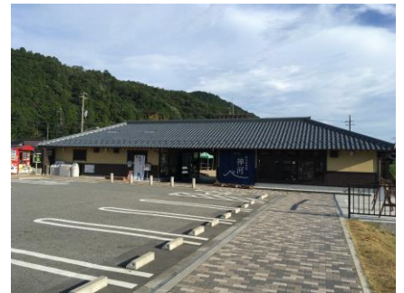
道の駅 「銀の馬車道・神河」（令和2年撮影）
