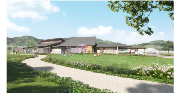
【敷地北西より建物を望む】
