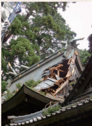
平成29年10月の倒壊状況
