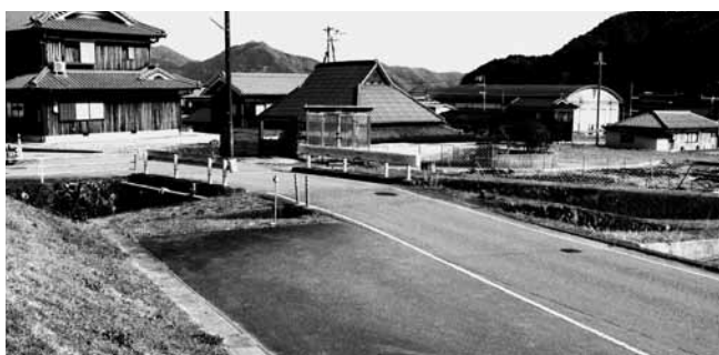
町道水走り中河原線 改良予定の橋梁部
