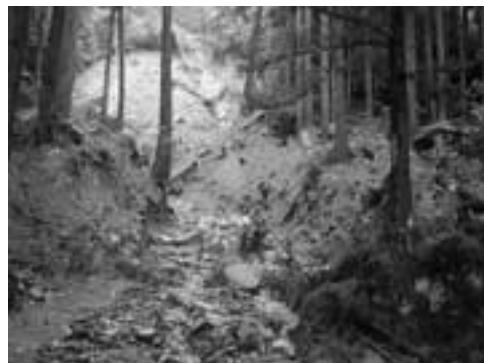
川上区でも雨により路肩斜面が崩壊し、現在も一部通行止めになっています。
