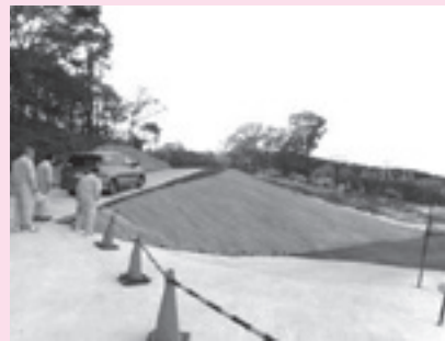
峰山高原施設内道路改修工事 (上小田区)
