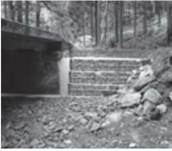
林道奥山支線1号橋工事状況
