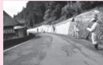
町道作畑・新田線 道路改良工事 (新田区)
