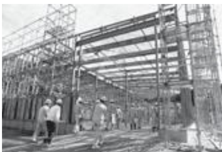
建設中の貸工場（福本区）
