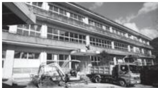
想い出残る学び舎解体
