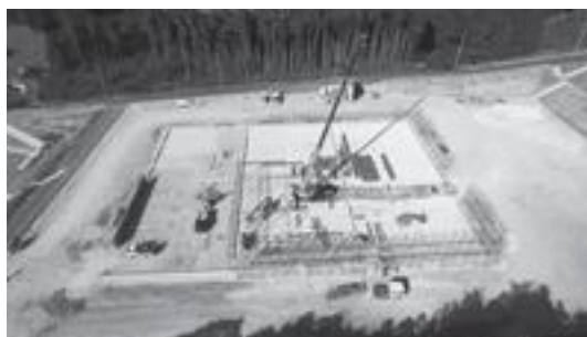
建設中の貸工場
