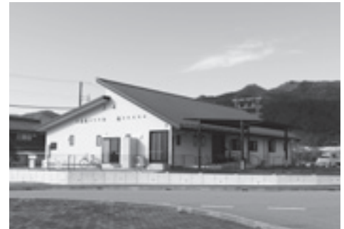
神崎支庁舎内に完成した多機能型施設「ひと花」
