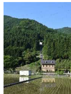
南小田第二発電所
