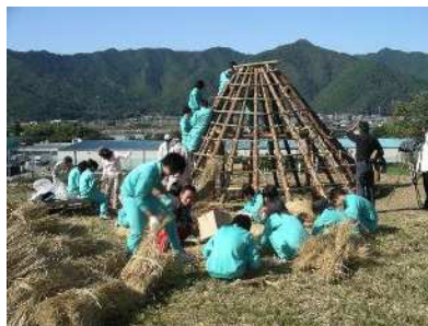
高校生による竪穴住居の葺き替え作業
