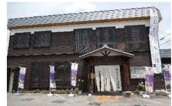
木造インターンシップにより改修された銀の馬車道交流館
