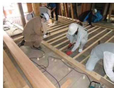
空き家の再生
