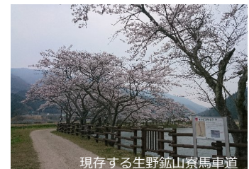
現存する生野鉱山寮馬車道
