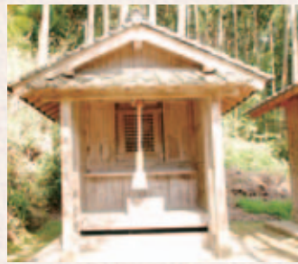
地蔵と弘法大師像が安置されているお堂
