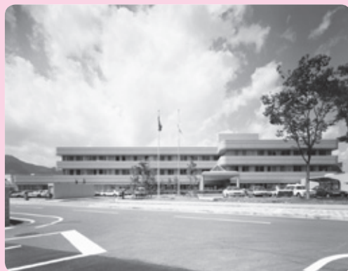
平成2年10月 公立神崎総合病院南館竣工
