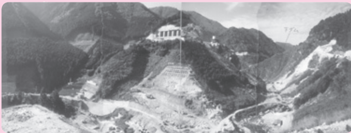
大河内水力発電所（工事中）
