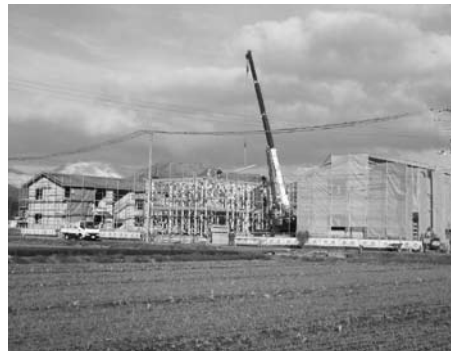
新野駅前建築中の低家賃住宅
