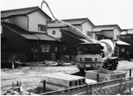
工事中の町営住宅柏尾団地
