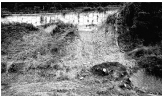
豪雨による土砂崩れ（町道赤田線周辺）
