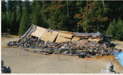
平成 29 年 10 月の倒壊状況
