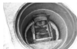
◀クリーン柵の蓋を開けたところ
