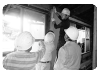
↑壁の柱を取り付ける作業
