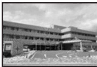
平成31年開設に向け、病院北館の改築工事がスタート
