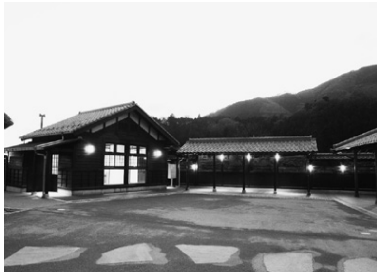
段差がなくなった飛石（道の駅）
