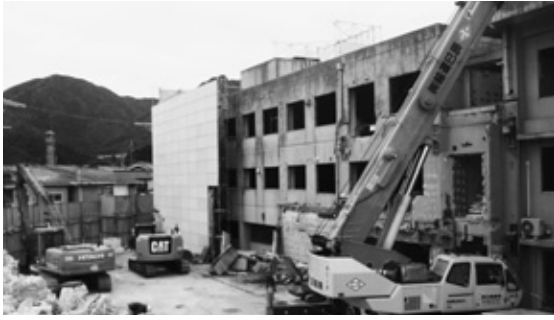
解体が始まった北館
