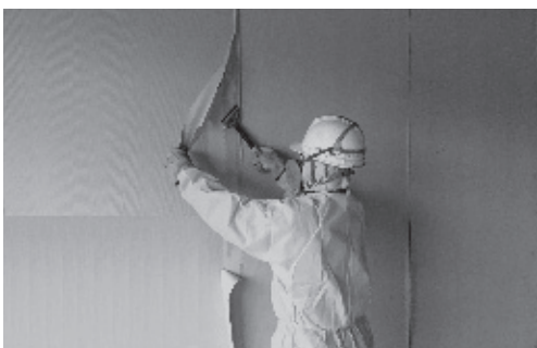
アスベスト除去作業
