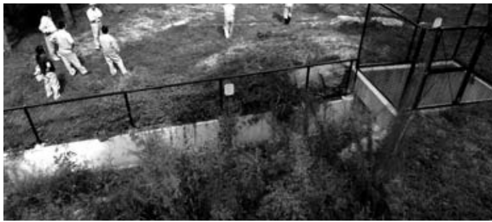
完成した山側の水路（越知谷小学校）
