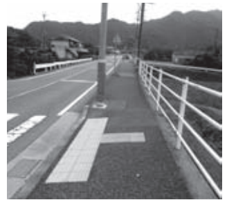
改良が望まれる歩道(加納区内)
