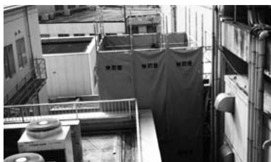
北館と中館の仮設通路工事
