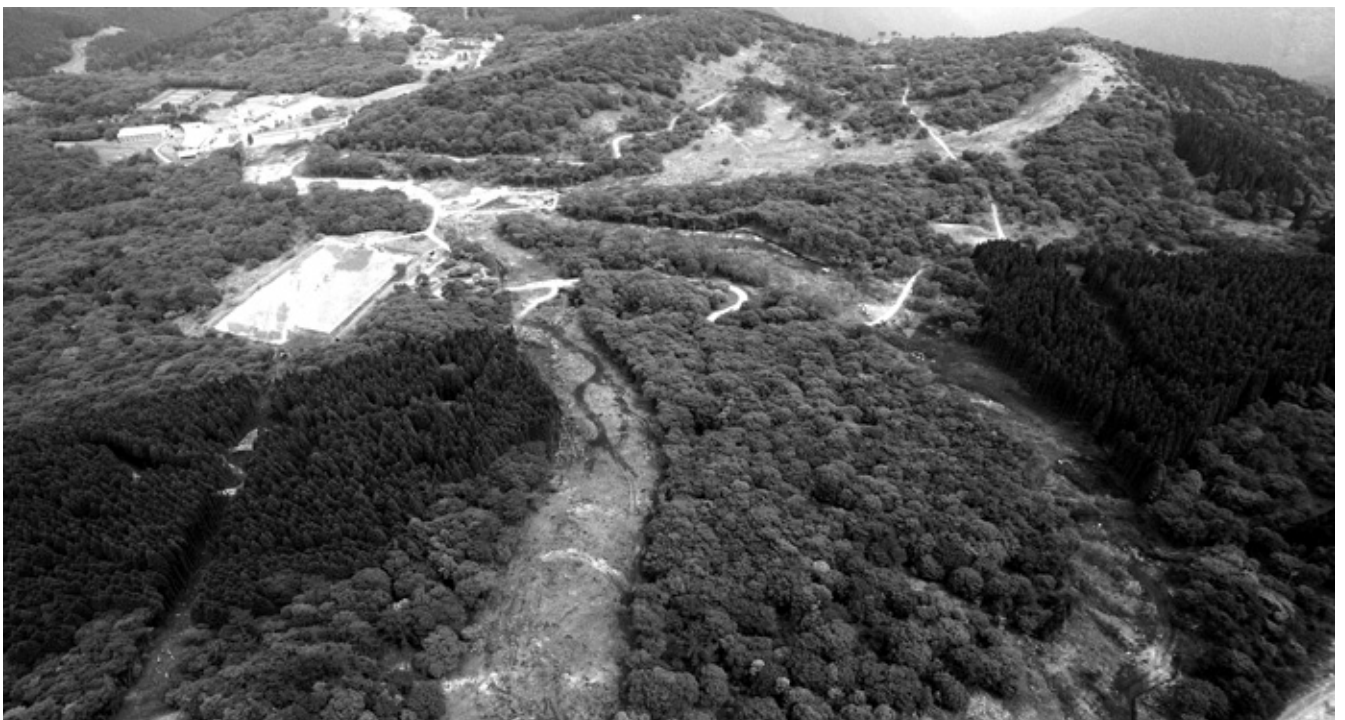
工事が進むスキー場（眺晴山より）
