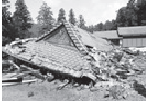
崩壊した春日神社の拝殿（吉富）
