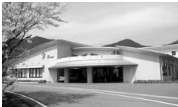
工事名 局舎増改築工事
