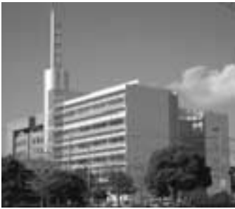
姫路防災センター
