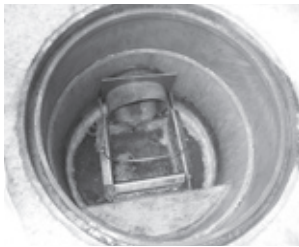
▲クリーン桝の蓋を開けたところ
