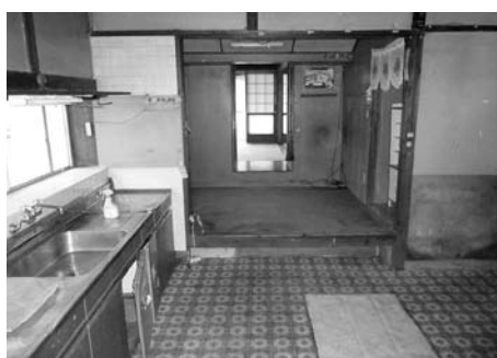
空き家の水回りの改修を助成します
